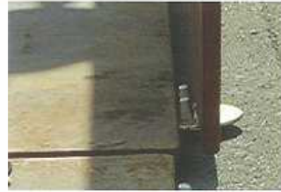
2.2枚目の敷鉄板を敷設してください。
