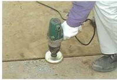
4.センターボルトの締め付けを行います。
