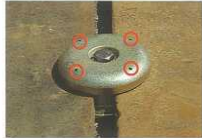
3.各々の敷鉄板にピンが2個ずつ噛んでいるか必ず確認してください。
