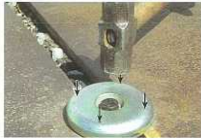
5.ハンマーでピンの穴部を強く叩きピンをより深く食い込ませてください。
